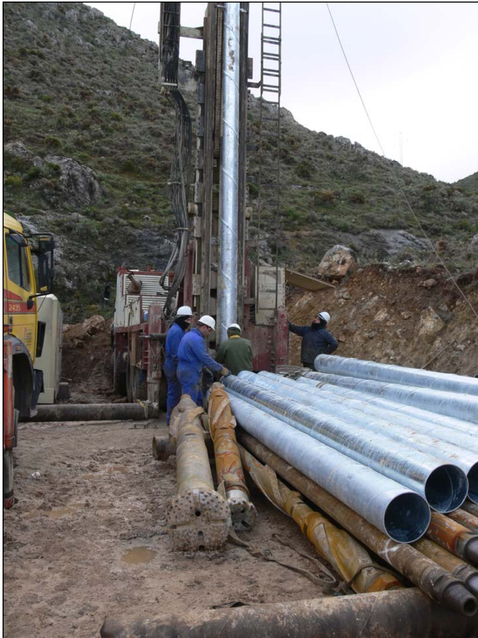
Fig. 9 –Instalación de tubería galvanizada en el sondeo de Almargen
